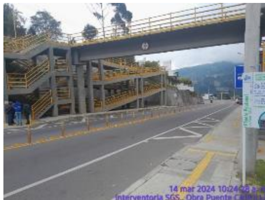
Foto 10: marzo 14 de 2024, panorámica del estado actual de señalización, demarcación y accesibilidad en PR0+289 (K9+645 Puente “Carulla”).
