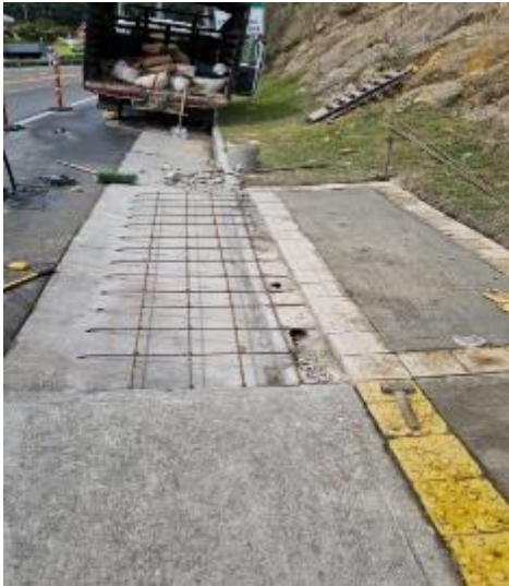
Foto 1: diciembre 15 de 2023, inicio ejecución de rampa de acceso a paradero en PR0+289 (K9+645 Puente “Carulla”), costado izquierdo.
