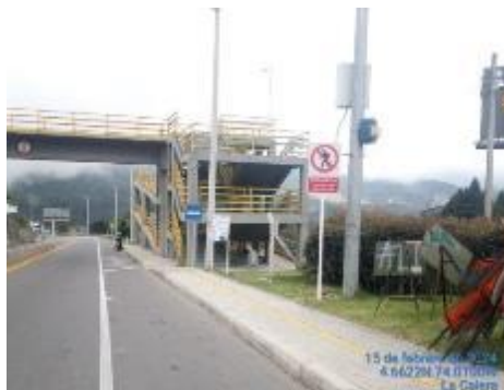
Foto 9: febrero 15 de 2024, instalación señalización en rampa de acceso a paradero en PR0+289 (K9+645 Puente “Carulla”), costado derecho.
