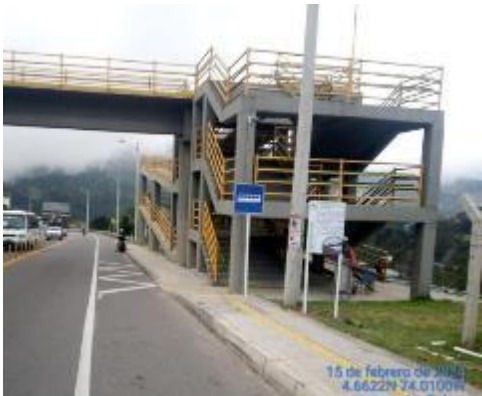
Foto 7: febrero 15 de 2024, instalación señalización en rampa de acceso a paradero en PR0+289 (K9+645 Puente “Carulla”), costado derecho.
