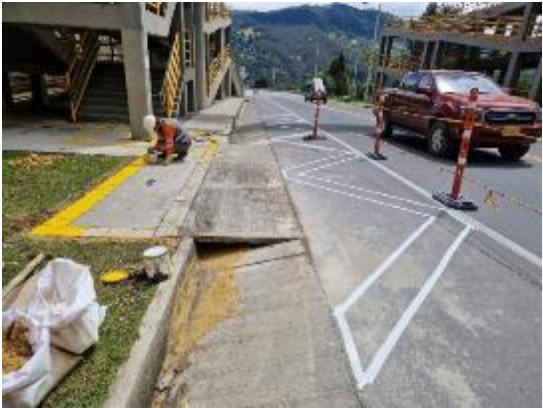
Foto 3: diciembre 15 de 2023, ejecución de rampa de acceso a paradero en PR0+289 (K9+645 Puente “Carulla”), costado derecho.
