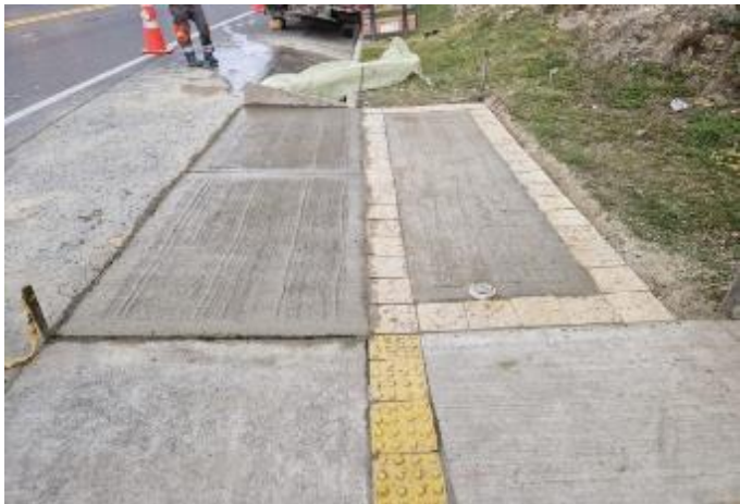
Foto 2: diciembre 15 de 2023, terminación ejecución de rampa de acceso a paradero en PR0+289 (K9+645 Puente “Carulla”), costado izquierdo.
