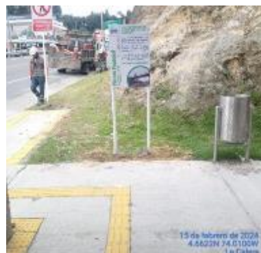
Foto 8: febrero 15 de 2024, instalación señalización en rampa de acceso a paradero en PR0+289 (K9+645 Puente “Carulla”), costado izquierdo.
