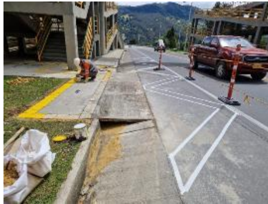
Foto 3: diciembre 15 de 2023, ejecución de rampa de acceso a paradero en PR0+289 (K9+645 Puente “Carulla”), costado derecho.
