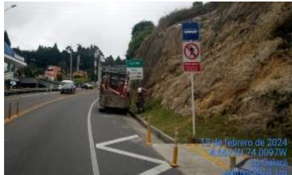
Foto 6: febrero 15 de 2024, instalación señalización en rampa de acceso a paradero en PR0+289 (K9+645 Puente “Carulla”), costado izquierdo.
