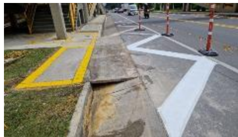
Foto 4: diciembre 15 de 2023, ejecución demarcación de rampa de acceso a paradero en PR0+289 (K9+645 Puente “Carulla”), costado derecho.
