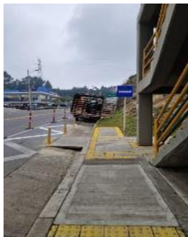
Foto 5: diciembre 15 de 2023, ejecución demarcación de rampa de acceso a paradero en PR0+289 (K9+645 Puente “Carulla”), costado izquierdo.
