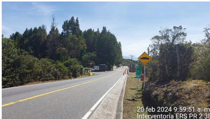
Ilustración 3 Área Constructiva del Peaje sin actividad por parte del Concesionario.
