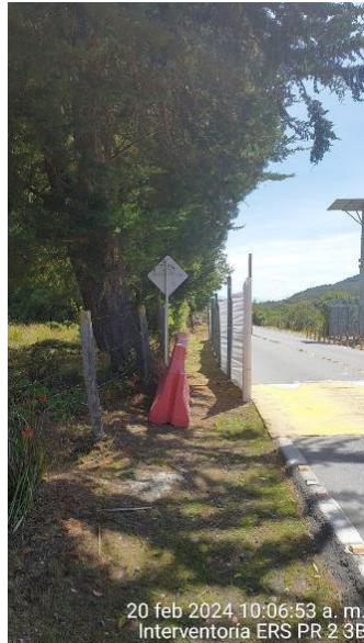
Ilustración 4 Costado izquierdo sentido Bogotá Choachí – con presencia de cerramiento perimetral.
