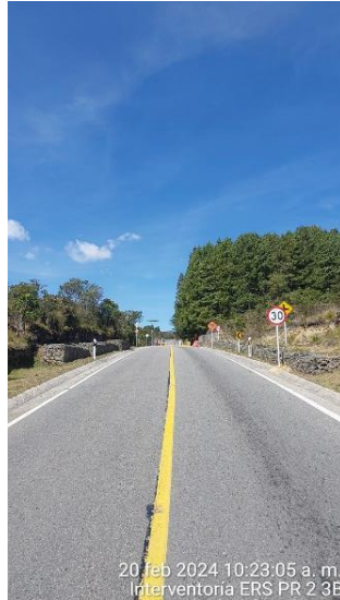
Ilustración 8 Área Constructiva del Peaje sin actividad por parte del Concesionario.
