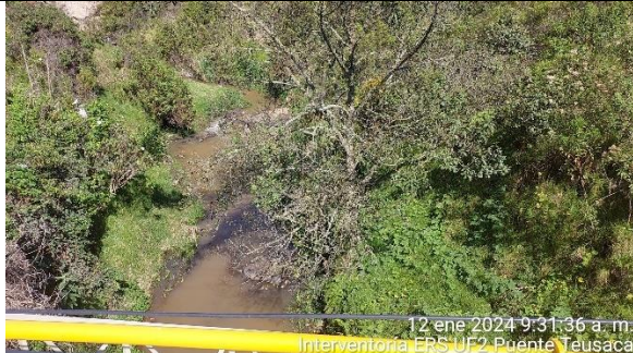
Ilustración 5 . Estado actual del cauce del Rio Teusacá – Sentido Occidental A.
