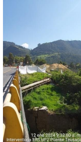
Ilustración 4 . Estado actual del cauce del Rio Teusacá – Sentido Oriental B.
