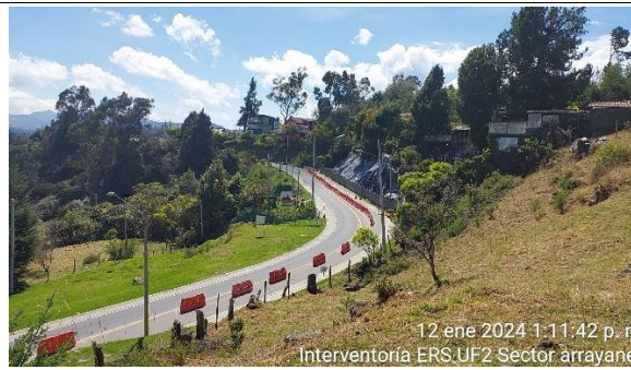
Ilustración 2 . Estado actual del talud de Arrayanes – Vista General.
