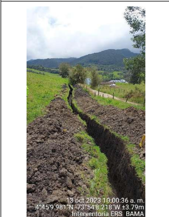
Ilustración 5 Zanja de la línea de aducción de la Bocatoma como estructura de contención del BAMA A.
