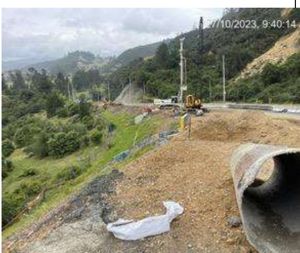
Ilustración 13 Área de trabajo con presencia de material.
