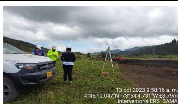
Ilustración 4. Verificación topográfica de las actividades Constructivas.
