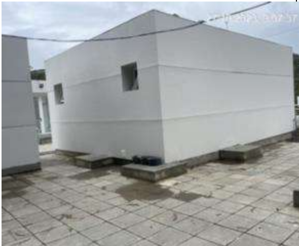
Ilustración 9 Evidencia de limpieza de las áreas generales del ADS B.
