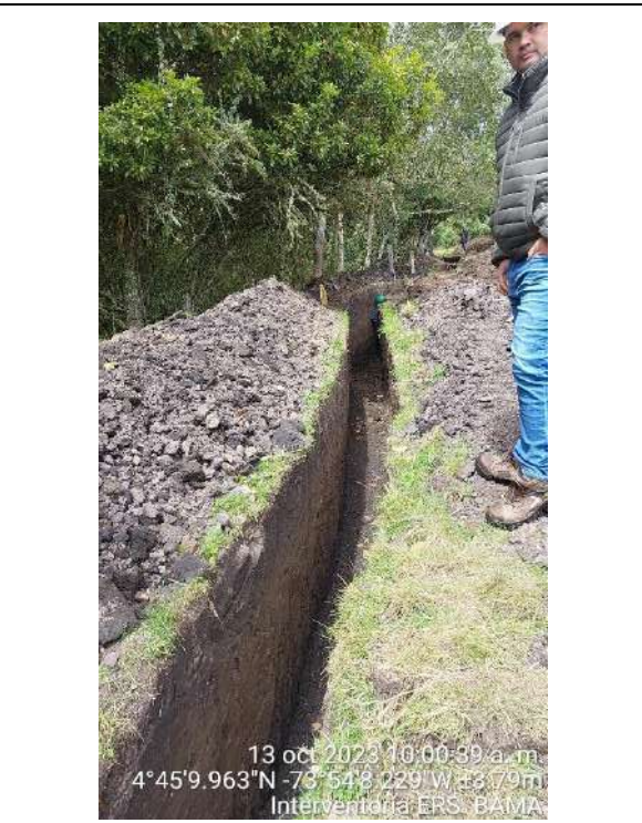
Ilustración 6 Zanja de la línea de aducción de la Bocatoma como estructura de contención del BAMA B.
