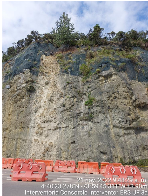
Figura 4-16 Señalización, Separadores físicos. Presencia de material sobre la canal y vía (alud). Restricción por un carril.
