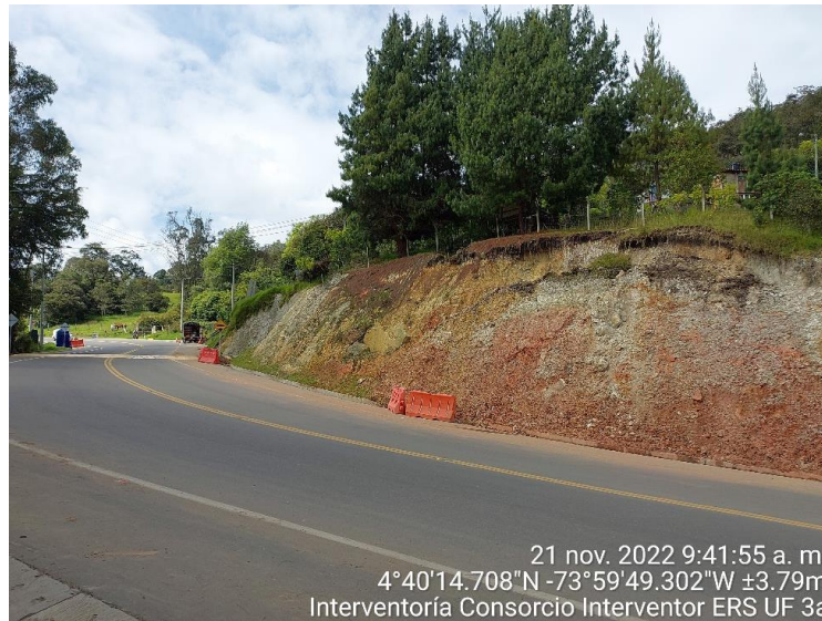
Figura 4-13 Evidencia de señalización y barreras mecánicas. Presencia de material sobre las canales (alud).
