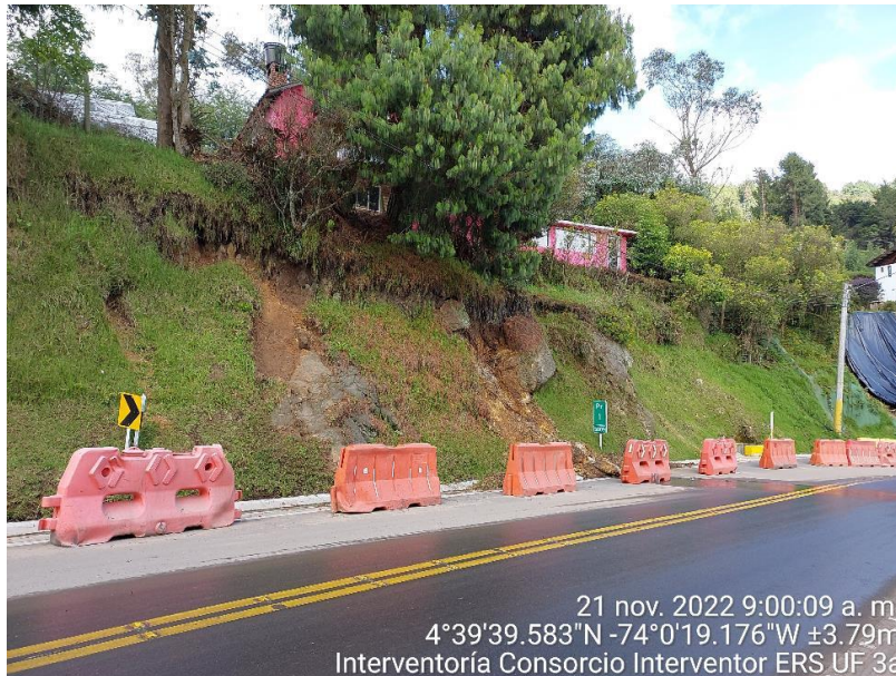
Figura 4-5 Señalización y Separadores físicos. Presencia de material sobre las canales (alud).
