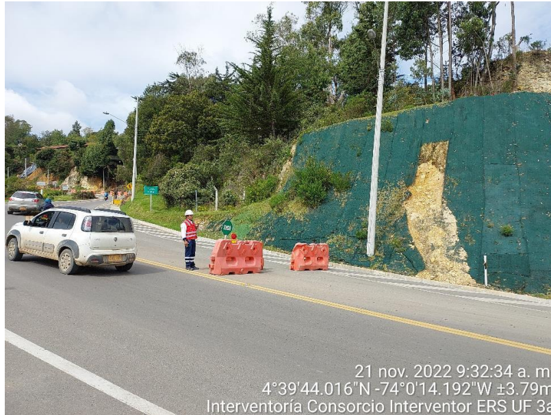
Figura 4-11 Evidencia de señalización y control de tráfico en los puntos críticos. Presencia de material sobre las canales (alud).
