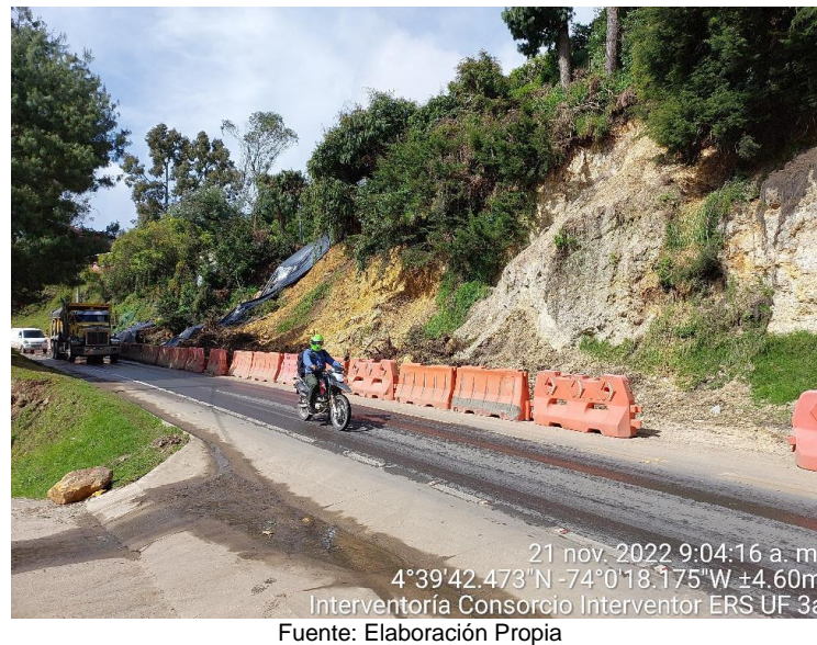
Figura 4-7 Señalización, Separadores físicos y protección temporal sobre el talud afectado. Presencia de material sobre las canales y vía (alud). Restricción por un carril.
