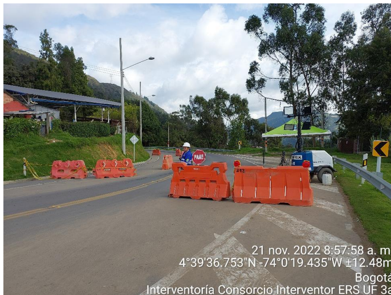
Figura 4-3 Evidencia de señalización y control de tráfico en los puntos críticos.
