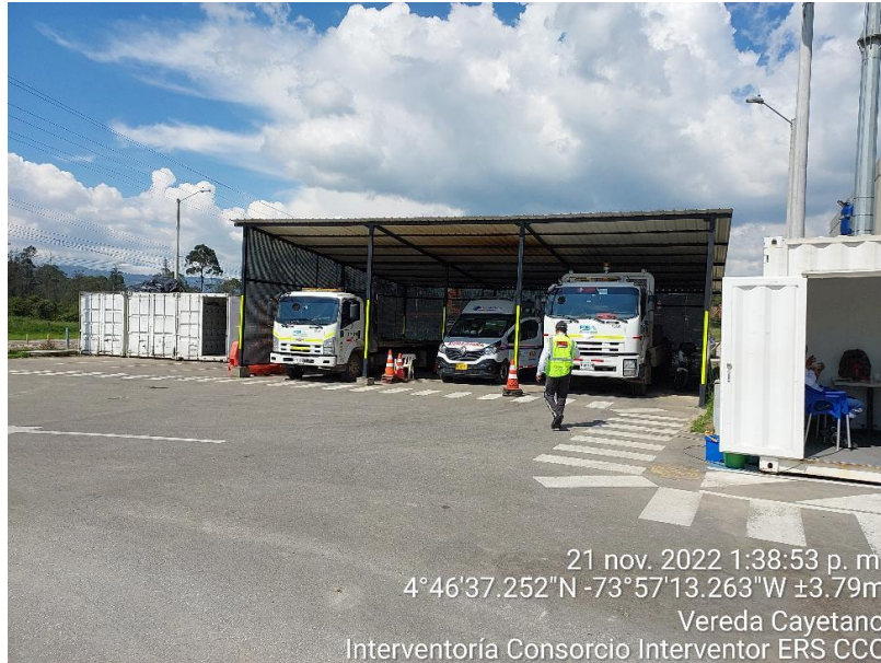
Figura 4-25 Instalación general del Área de Servicio CCO.
