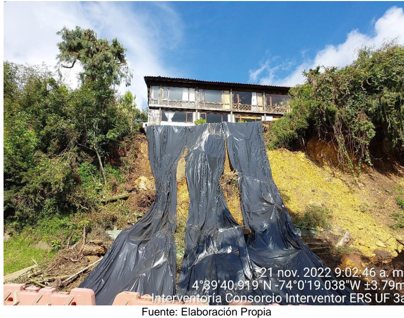
Figura 4-7 Señalización, Separadores físicos y protección temporal sobre el talud afectado. Presencia de material sobre las canales y vía (alud). Restricción por un carril.
