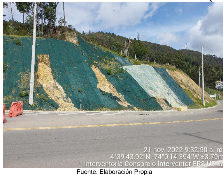
Figura 4-11 Evidencia de señalización y control de tráfico en los puntos críticos. Presencia de material sobre las canales (alud).
