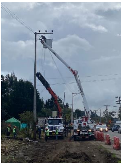
Traslado de postes de Telefónica-Movistar.
