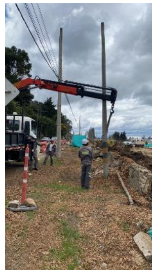
Traslado de postiería y redes aéreas de MT y BT de Codensa.
