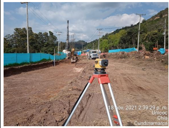
FOTOGRAFÍA N° 0009 FECHA: 18-nov.-21 DESCRIPCIÓN Verificación de niveles para excavación de estructura de vía margen izquierdo Calzada Occidental entre abscisas K3+460 al K3+530, UF1
