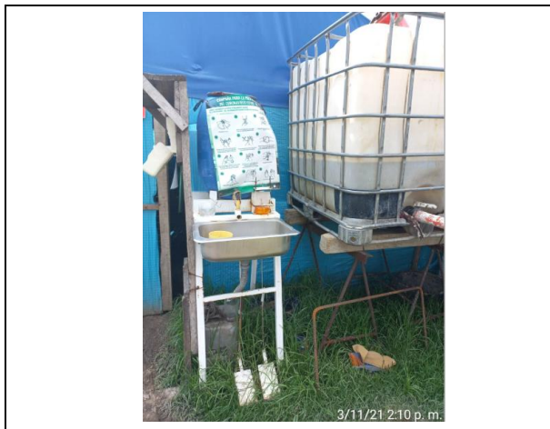
FOTOGRAFÍA N° 8 FECHA: 3-nov.-21 DESCRIPCIÓN UF4, Puente peatonal Aposentos: Punto de lavado de manos (Separador central)
