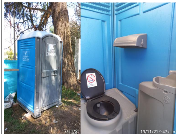
FOTOGRAFÍA N° 26 FECHA: 17-nov.-21 DESCRIPCIÓN UF1, Contratista Mincivil: Baños portátiles disponibles en calzada occidental (RN 5501 PR3+650)
