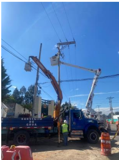
Traslado de postiería y redes aéreas de MT y BT de Codensa.
