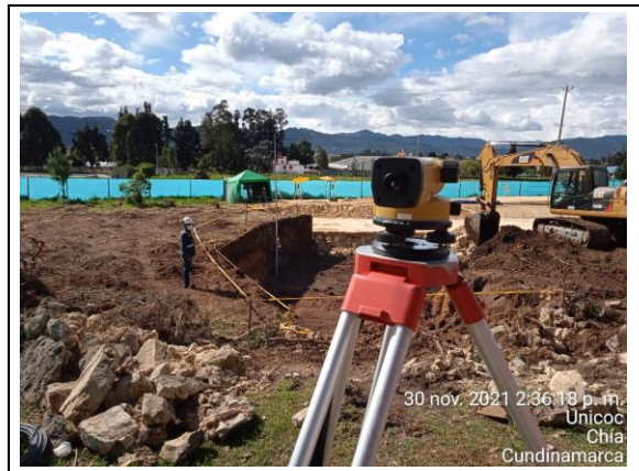
FOTOGRAFÍA N° 0012 FECHA: 30-nov.-21 DESCRIPCIÓN Verificación de niveles para excavación de estructura de vía en Retorno No. 3, Calzada Occidental Unidad Funcional No 1.
