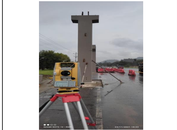
FOTOGRAFÍA N° 0010 FECHA: 23-nov.-21 DESCRIPCIÓN Verificación de verticalidad en columnas para Puente peatonal Yerbabuena, sobre costados oriental y occidental.
