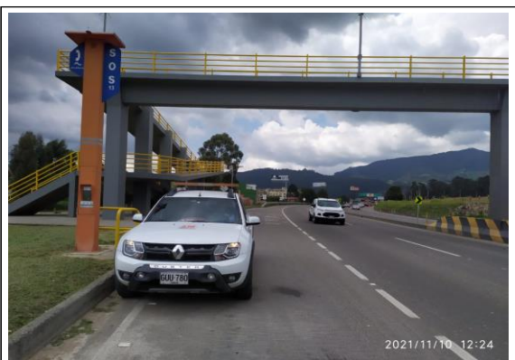
FOTOGRAFÍA N° 0021 FECHA: 25/10/2021 RN 45A04, 45ACNA, 45ACNB Verificación de la comunicación por medio de postes SOS con radioperadores en el CCO.
