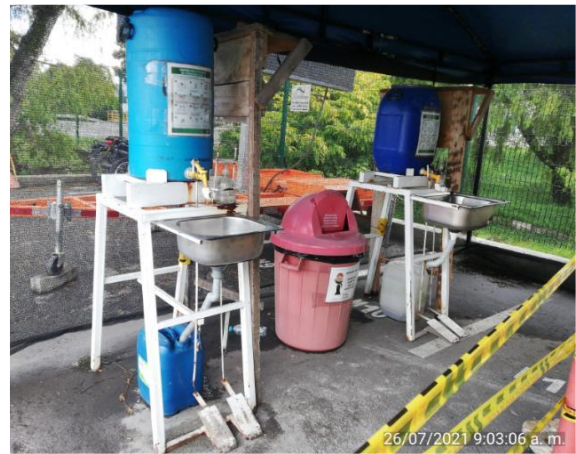
FOTOGRAFÍA N° 2 FECHA: 26-jul.-21 DESCRIPCIÓN UF2, CCO: Puntos de lavado de manos
