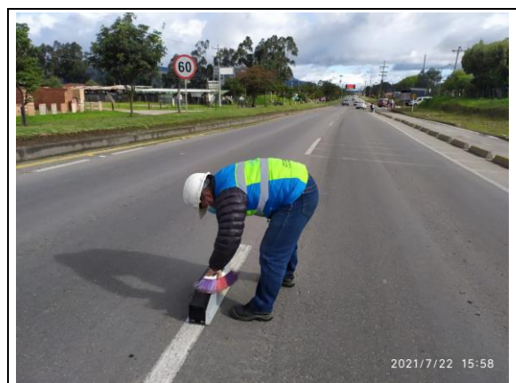
FOTOGRAFIA N° 0022 FECHA: 22/07/2021 RN 45A04 Zipaquirá - Capellanía. Medición al indicador E12 Señalización horizontal
