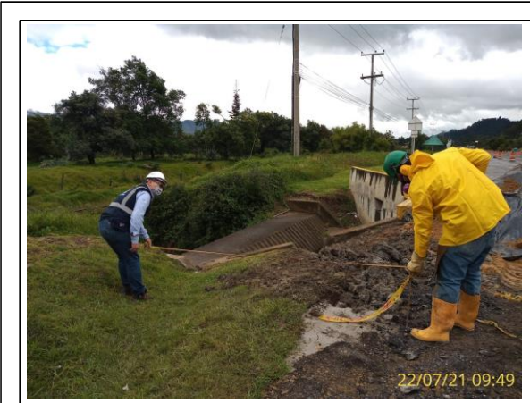
FOTOGRAFIA N° 0023 FECHA: 22/07/2021 Puente peatonal Ladrillera costado occidental verificación distanciamiento de pilotes a tubería tibitoc 2.90m
