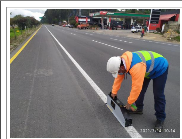
FOTOGRAFIA N° 0005 FECHA: 14/07/2021 RN 5501 Calzada Oriental. Acompañamiento a medición de indicador semestral E12 Señalización horizontal
