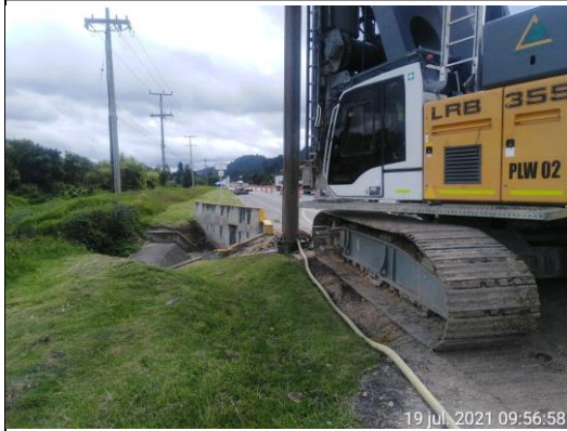
FOTOGRAFÍA N° 0009 FECHA: 19-jul.-21 DESCRIPCIÓN Verificación estado de avance de construcción de puentes peatonales, sobre Unidad Funcional No 4.
