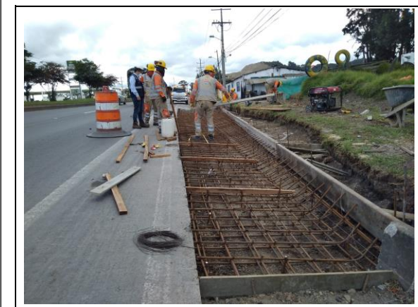
FOTOGRAFIA N° 0007 FECHA: 15/07/2021 Verificación de la construcción de cunetas reforzadas, Ruta 45A, PR19+000 costado occidental
