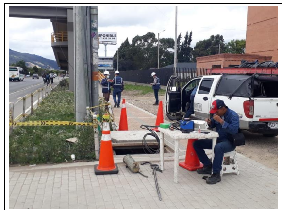
FOTOGRAFIA N° 0020 FECHA: 17/07/2021 Puente Peatonal Cundinamarca, Seguimiento al avance de la adecuación de Redes
