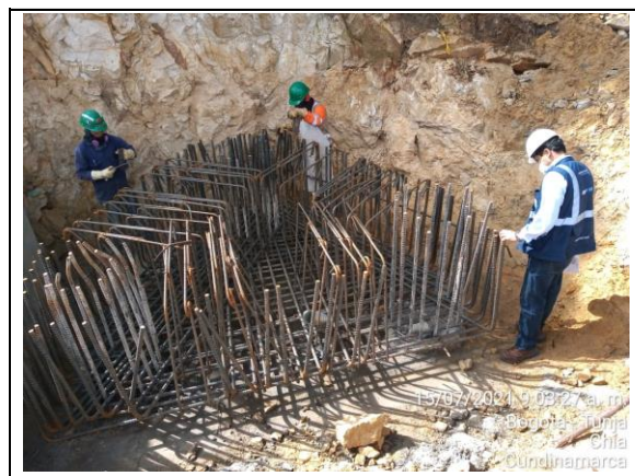
FOTOGRAFIA N° 0008 FECHA: 15/07/2021 U.F.4, Puente Peatonal Yerbabuena seguimiento a labores de armado estructura aceros dado pila eje 3, revisión cantidades, calzada oriental.
