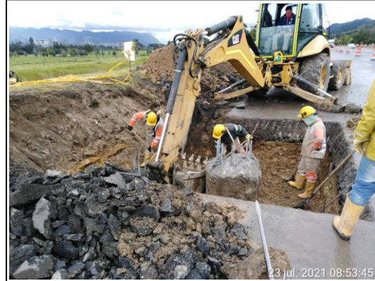
FOTOGRAFÍA N° 0010 FECHA: 23-jul.-21 DESCRIPCIÓN Verificación estado de avance de construcción de puentes peatonales, sobre Unidad Funcional No 4.
