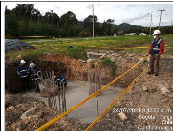
FOTOGRAFIA N° 0026 FECHA: 24/07/2021 U.F.4, fundida solao, dado eje 1, puente peatonal Pricemart, calzada oriental
