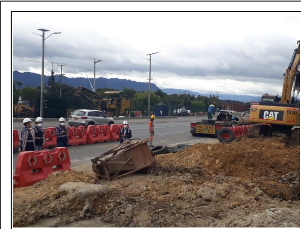
FOTOGRAFIA N° 0017 FECHA: 17/07/2021 Puente Peatonal Ladrillera seguimiento a labores en margen Oriental, se evidencia construcción de 26 Pilotes de 24 m.
