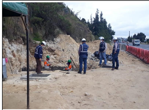
FOTOGRAFIA N° 0018 FECHA: 17/07/2021 Puente peatonal yerbabuena, armado de aceros dado pasarela margen Oriental
