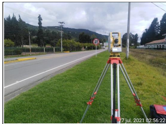
FOTOGRAFÍA N° 0012 FECHA: 27-jul.-21 DESCRIPCIÓN Levantamiento topográfico de vía existente y revisión de poligonal, carrera séptima UF1 entre abcisas K5+120 al K4+950.
