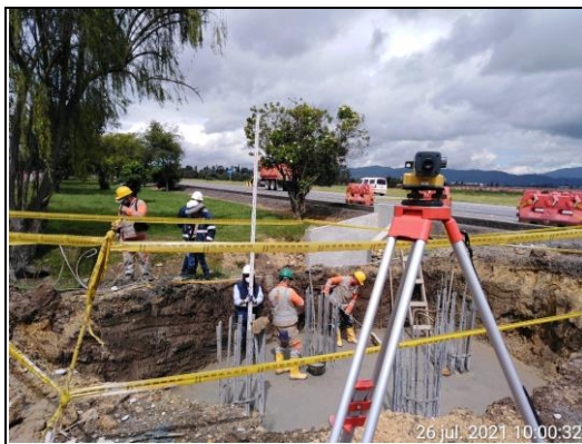
FOTOGRAFÍA N° 0011 FECHA: 26-jul.-21 DESCRIPCIÓN Levantamiento topográfico y niveles acero de pilotes, concreto de limpieza eje pila 1, eje pila 2, modulo de inicio puente Price Smart.
