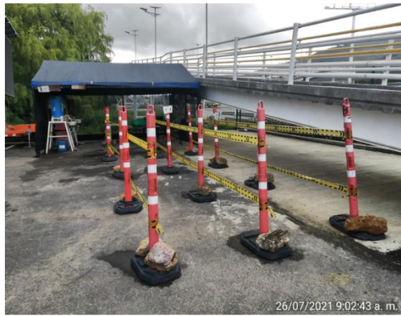
FOTOGRAFÍA N° 1 FECHA: 26-jul.-21 DESCRIPCIÓN UF2, CCO: Punto de habilitación
