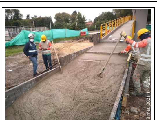
FOTOGRAFÍA N° 0010 FECHA: 8/03/2021 Seguimiento a la construcción del módulo de inicio en ciclopeo, rampa oriental Puente Peatonal Manuela Beltrán
