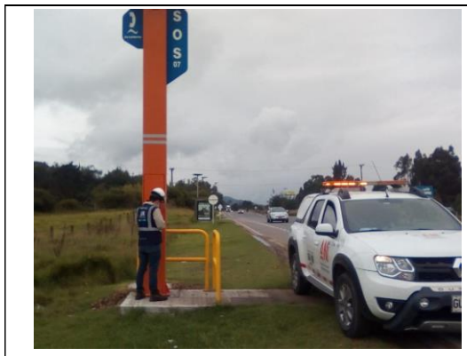
FOTOGRAFÍA N° 0025 FECHA: 18/03/2021 Revisión estado postes SOS por parte de la Interventoría
