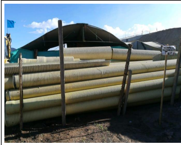
FOTOGRAFÍA N° 12 FECHA: 22-ene.-21 DESCRIPCIÓN UF3, Sector humero: Mejora en la instalación y soporte de los rollizos para acopio de tubería.
