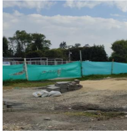
FOTOGRAFÍA N° 8 FECHA: 29-ene.-21 DESCRIPCIÓN UF4, Puente peatonal ubicado la universidad Manuela Beltrán: Se modifica la metodología de acopio de bordillos, se realiza de manera horizontal y apilado, para garantizar estabilidad del material
