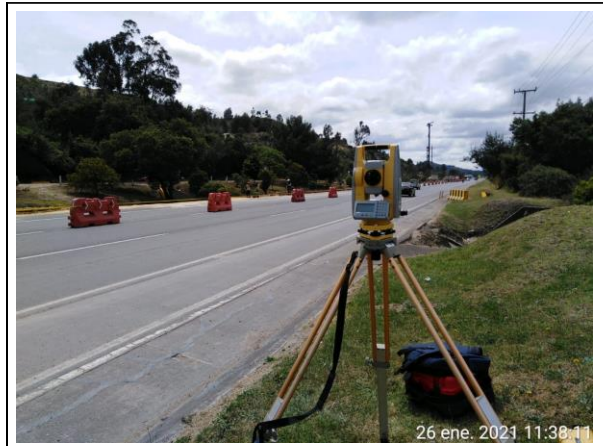
FOTOGRAFÍA N° FECHA: 26-ene.-21 DESCRIPCIÓN Levantamiento topográfico en ampliación de vía zona Puente Peatonal Tinjacá Yerbabuena.
