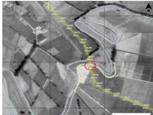
Gráfico 13 Localización General. Puente Sobre el Rio Bogotá- Calzada Norte y Calzada Sur-
