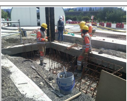
FOTOGRAFÍA N° 0016 FECHA: 8/01/2021 U.F.4, C.C.O. Briceño, armado estructura cuarto maquinas
