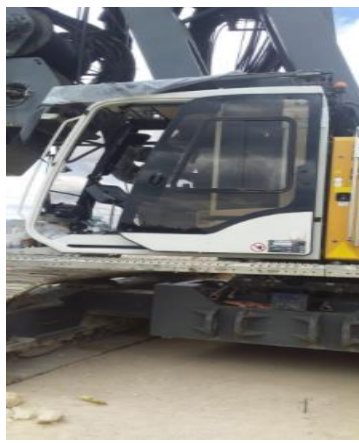
FOTOGRAFIA N° 14 FECHA: 29-ene.-21 DESCRIPCIÓN UF4, Puente peatonal ubicado en Yerbabuena: Se realiza mantenimiento e instalación de vidrio en puerta de la piloteadora como acción correctiva
