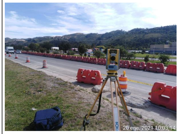
FOTOGRAFÍA N° FECHA: 20-ene.-21 DESCRIPCIÓN Levantamiento topográfico en ampliación de vía zona Puente Peatonal Price Smart.
