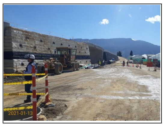
FOTOGRAFÍA N° 0028 FECHA: 13/01/2021 U.F.3. Sector el Humero, Actividades de Inspección de Interventoría
