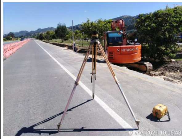
FOTOGRAFÍA N° FECHA: 19-ene.-21 DESCRIPCIÓN Toma de secciones transversales en ampliación de vía zona Puente Peatonal Price Smart.
