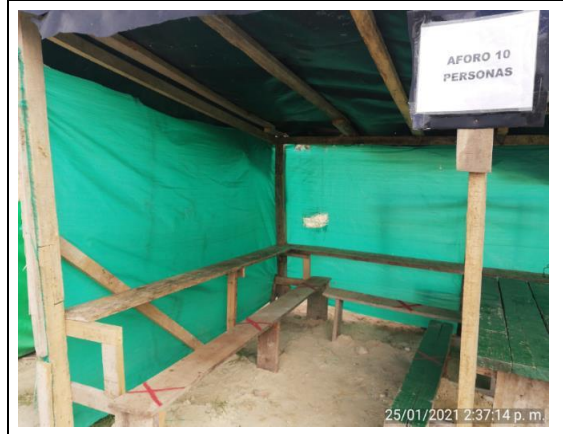
FOTOGRAFÍA N° 58 FECHA: 25-ene.-21 DESCRIPCIÓN UF4, Puente peatonal ubicado en Yerbabuena: Se realiza instalación de señalización con aforo máximo en área del comedor
