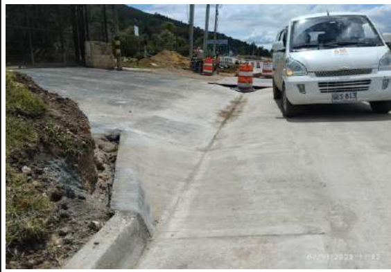
FOTOGRAFÍA N° 0011 FECHA: 02/11/2023 UF1, K2+420 - K2+450 seguimiento a la construcción de secciones cuneta, para acceso vía Portal de Fusca.
