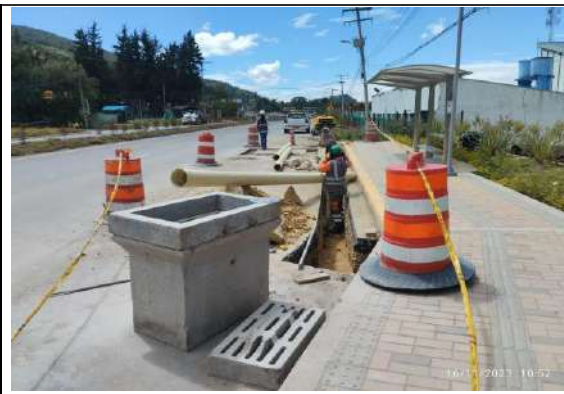
FOTOGRAFÍA N° 0013 FECHA: 16/11/2023 K2+620 seguimiento a actividades de excavación, instalación tubería y sumidero prefabricado, bahía paradero puente peatonal Pórtico.
