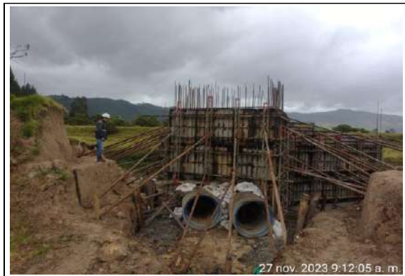
FOTOGRAFÍA N° 0016 FECHA: 27/11/2023 Construcción Obra hidráulica para entregar al Río Bogotá las aguas de la alcantarilla ubicada en la variante de Cajicá PR4+900
