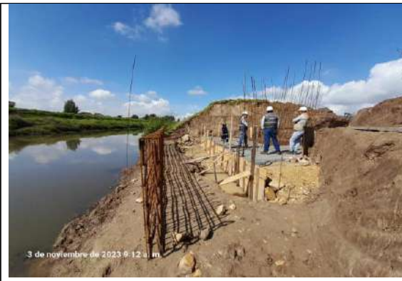
FOTOGRAFÍA N° 0015 FECHA: 03/11/2023 Construcción Obra hidráulica para entregar al Río Bogotá las aguas de la alcantarilla ubicada en la variante de Cajicá PR4+900
