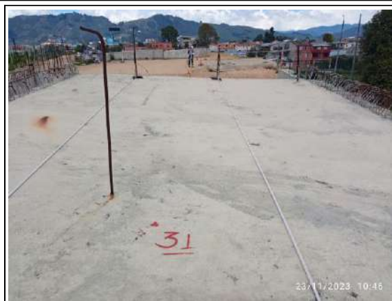
FOTOGRAFÍA N° 0010 FECHA: 23-nov.-23 DESCRIPCIÓN Inspección visual de posibles fisuras en placas superiores de Box Couvert 1 y 2 Intersección Húmero UF3.
