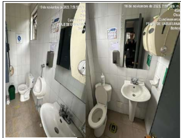
FOTOGRAFÍA N° 6 FECHA: 10-nov.-23 DESCRIPCIÓN UF4, Peaje Unisabana: Punto de lavado de manos. Disponibilidad de agua y recordatorio de lavado de manos.
