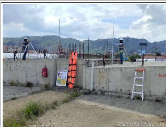
FOTOGRAFÍA N° 0009 FECHA: 23-nov.-23 DESCRIPCIÓN Control de asentamientos en placas superiores de Box Couvert 1 y 2 Intersección Húmero UF3.
