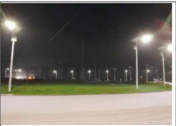
FOTOGRAFÍA N° 0022 FECHA: 10/11/2023 RN 45ACNB Glorieta Portachuelo, medición indicador E14 Iluminación
