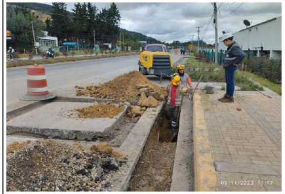
FOTOGRAFÍA N° 0012 FECHA: 09/11/2023 UF1, K2+620 seguimiento a actividades de excavación, instalación tubería y sumidero prefabricado, bahía paradero puente peatonal Pórtico, costado occidental.
