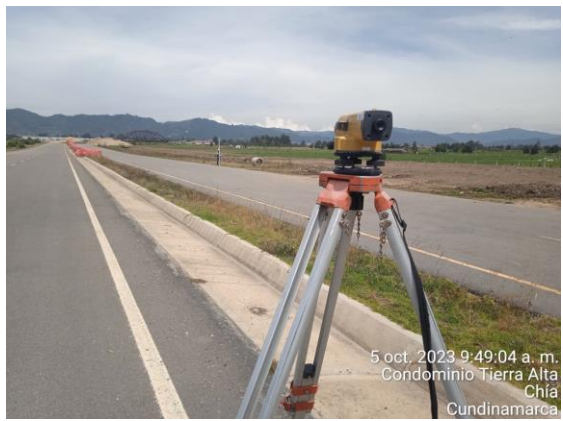
FOTOGRAFÍA N° 0003 FECHA: 5-oct.-23 DESCRIPCIÓN Verificación de niveles actuales de asfalto en Unidad Funcional No 3 del K0+700 al K2+180 Ramal de Salida
