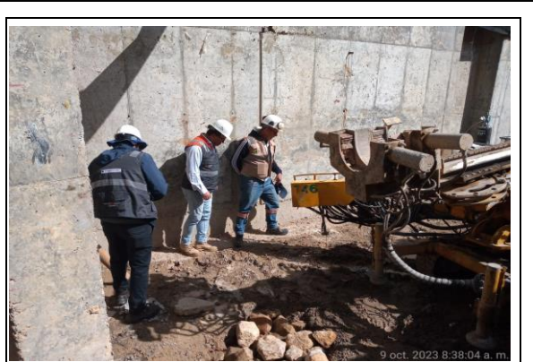
FOTOGRAFIA N° 0024 FECHA: 09/10/2023 Inspección de seguimiento U.F.3., Intersección El Humero Visita especialista geotecnia
