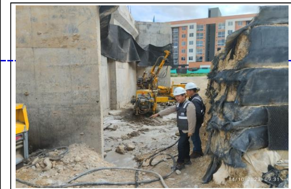
FOTOGRAFIA N° 0025 FECHA: 14/10/2023 Inspección de seguimiento U.F.3., Intersección El Humero
