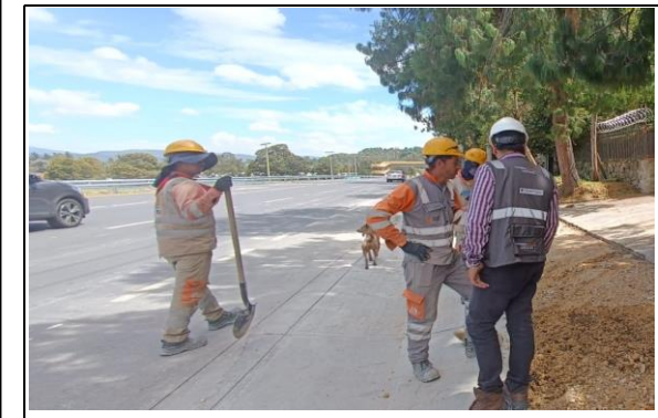
FOTOGRAFIA N° 0009 FECHA: 07/10/2023 Seguimiento a actividades de adecuación accesos en predios UF.1.
