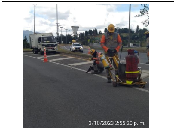
FOTOGRAFIA N° 0014 FECHA: 03/10/2023 Seguimiento desde el área de operación a la instalación de tachas, sector de convergencia vías Ubaté - Zipaquirá, ruta 45A04, PR22+800, costado occidental.
