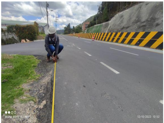
FOTOGRAFÍA N° 0005 FECHA: 12-oct.-23 DESCRIPCIÓN Verificación de nueva localización de PRs en calzada izquierda y derecha Unidad Funcional No 1.
