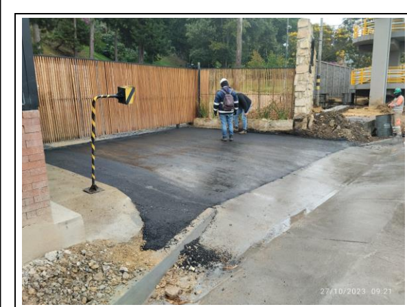
FOTOGRAFIA N° 0017 FECHA: 27/10/2023 U.F.1., K1+300 Seguimiento a las actividades de conformación, mejoramiento acceso predio Condominio Tundama, calzada derecha.
