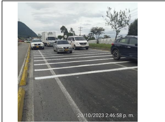
FOTOGRAFIA N° 0016 FECHA: 20/10/2023 Seguimiento desde el área de operación al repinte de líneas logarítmicas, PR18+000, ruta 45A04, calzada occidental.
