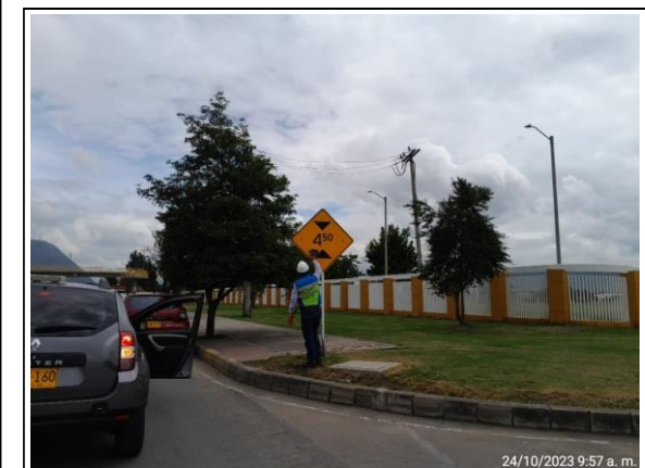
FOTOGRAFIA N° 0021 FECHA: 24/10/2023 RN 45A04 PR 16+500 calzada oriental, medición del indicador E11 señalización vertical.
