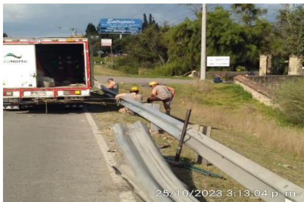
FOTOS 17 y 18: Actividades de cambio y mantenimiento de defensas metálicas y captafaros, ruta 5501, calzada oriental sector de Sindamanoy.
