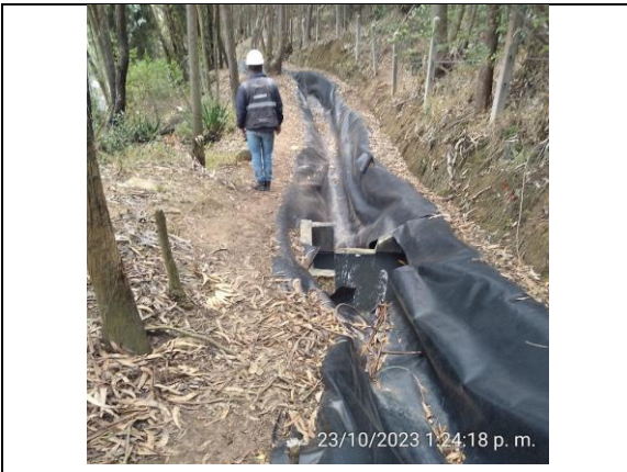
FOTOGRAFIA N° 0020 FECHA: 23/10/2023 Seguimiento desde el área de operación y Recorrido de verificación del talud Portachuelo, revisión de zanjas de coronación y cajas de paso, PR22+800, ruta 45A04.
