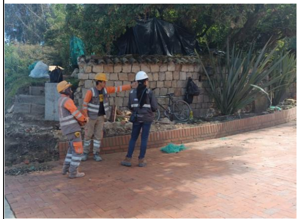
FOTOGRAFIA N° 0012 FECHA: 07/10/2023 Seguimiento al avance de actividades de adecuación de predios, corte de adoquín para cañuela, predio Bosques de Torca.
