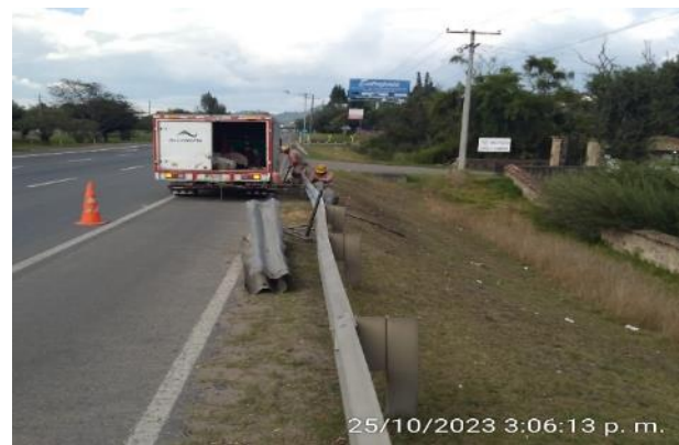
FOTOS 17 y 18: Actividades de cambio y mantenimiento de defensas metálicas y captafaros, ruta 5501, calzada oriental sector de Sindamanoy.
