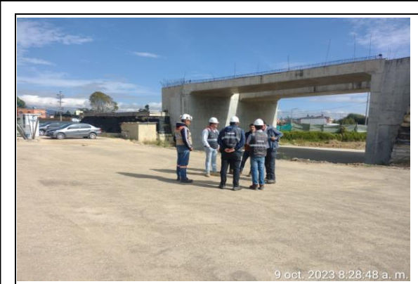
FOTOGRAFIA N° 0023 FECHA: 09/10/2023 Inspección de seguimiento U.F.3., Intersección El Humero Visita especialista geotecnia
