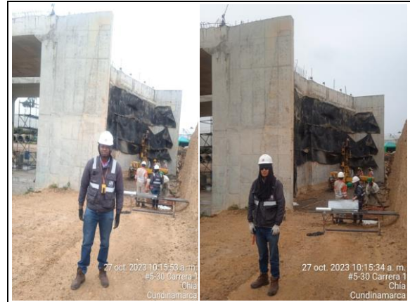
FOTOGRAFÍA N° 0012 FECHA: 27-oct.-23 DESCRIPCIÓN Verificación avance de actividades en Box Coulvert 1 Intersección Húmero Unidad Funcional No. 3.
