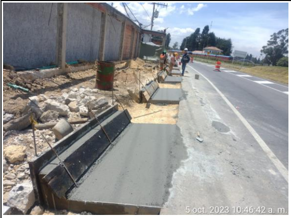
FOTOGRAFIA N° 0018 FECHA: 05/10/2023 Seguimiento a las actividades de construcción de cunetas costado oriental K5+100 U.F.1.
