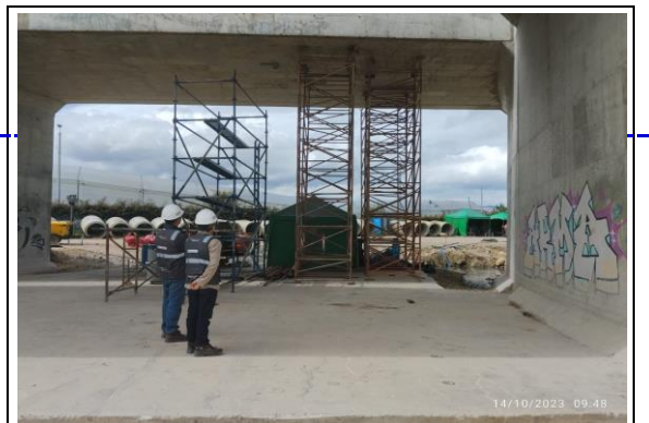
FOTOGRAFIA N° 0026 FECHA: 14/10/2023 Inspección de seguimiento U.F.3., Intersección El Humero
