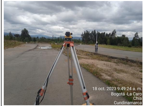
FOTOGRAFÍA N° 0006 FECHA: 18-oct.-23 DESCRIPCIÓN Control de asentamientos en Calzadas: Norte y Sur del K1+690 al K1+800 (Zona de geobloques). Unidad Funcional No 3.
