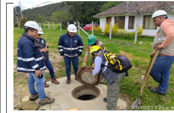
FOTOGRAFIA N° 0027 FECHA: 17/10/2023 Inspección de seguridad y verificación de cumplimiento normativo en puntos de alcantarillado longitudinal y transversal en U.F.1.
