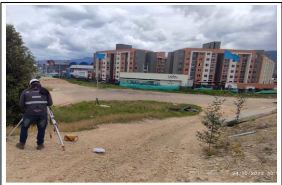
FOTOGRAFIA N° 0010 FECHA: 24/10/2023 Control de asentamientos en placas inferiores de Box Couvert 1 y 2 Intersección Húmero UF3.
