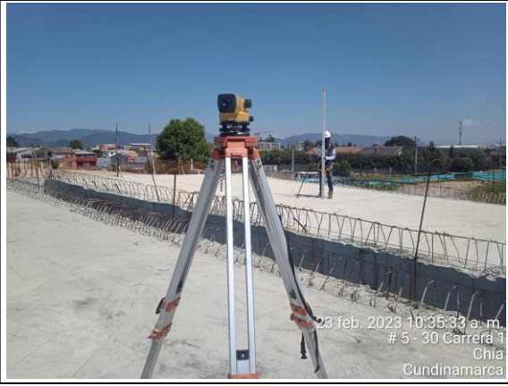
FOTOGRAFÍA N° 0011 FECHA: 23-feb.-23 DESCRIPCIÓN Control periódico de asentamientos, sobre placas superiores de Box Coulvert 1 y 2 intersección el Humero. Unidad Funcional No 3.
