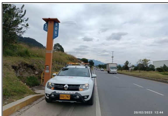
FOTOGRAFÍA N° 0014 FECHA: 20/02/2023 RN 45A04, 45ACNA, 45ACNB Verificación comunicación por medio de postes SOS con radioperadores en CCO.
