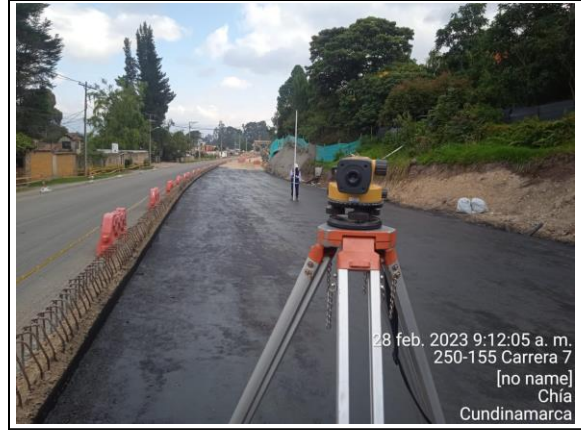
FOTOGRAFÍA N° 0012 FECHA: 28-feb.-23 DESCRIPCIÓN Verificación de niveles de sub base de altas prestaciones entre abscisas K0+950 al K1+130, calzada derecha Unidad Funcional No 1.
