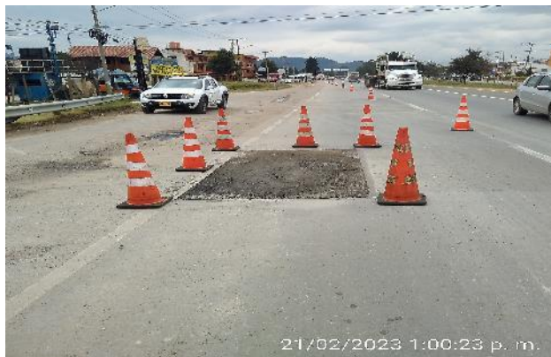
FOTOS 1 y 2: Actividades de aplicación de mezcla densa ruta 5501 PR21+900 calzada oriental, carril de baja, ejecutadas durante el mes de febrero de 2023.
