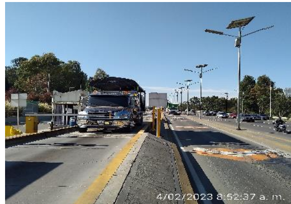
FOTOS 23 y 24: Estación de pesaje Andes, conformada por básculas dinámica y estática, carril de escape, estación de control y áreas de parqueo.
