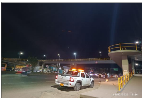
FOTOGRAFÍA N° 0013 FECHA: 16/02/2023 RN 45A04 PR11+300 Medición del Indicador Iluminación Puente peatonal Fibrit.
