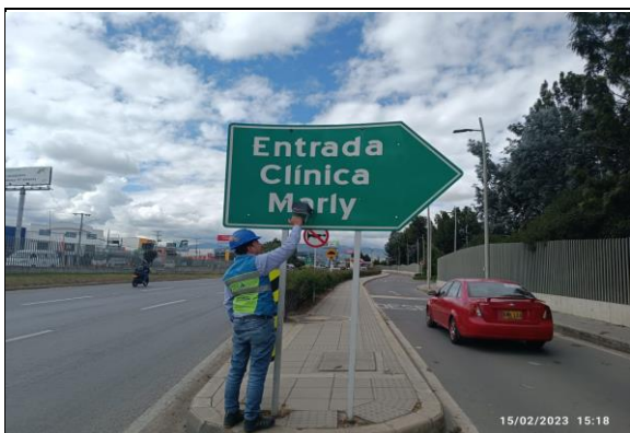
FOTOGRAFÍA N° 0011 FECHA: 15/02/2023 RN 45A04 Centro Chía - JR. Medición al indicador E11- Señalización Vertical
