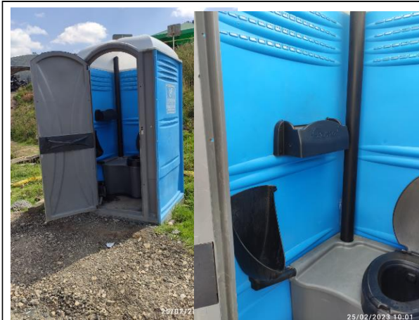
FOTOGRAFÍA N° 13 FECHA: 25-feb.-23 UF1, K2+080 Peaje Fusca costado occidental: Baño portátil sin lavamanos (Mincivil)
