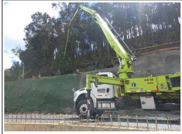
FOTOGRAFÍA N° 32 FECHA: 14-feb.-23 UF1, K3+260: Trabajo en altura durante la fundida y aplicación de concreto lanzado para aseguramiento de talud
