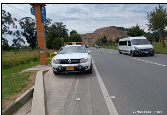
FOTOGRAFÍA N° 0015 FECHA: 20/02/2023 RN 45A04, 45ACNA, 45ACNB Verificación comunicación por medio de postes SOS con radioperadores en CCO.
