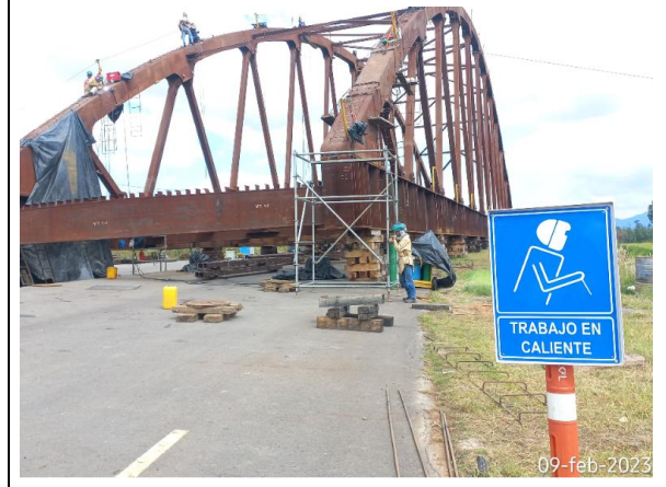
FOTOGRAFÍA N° 34 FECHA: 9-feb.-23 UF3, Sector Cuemavaca: Trabajo en caliente por aplicación de soldadura en construcción y conformación de puente vehicular
