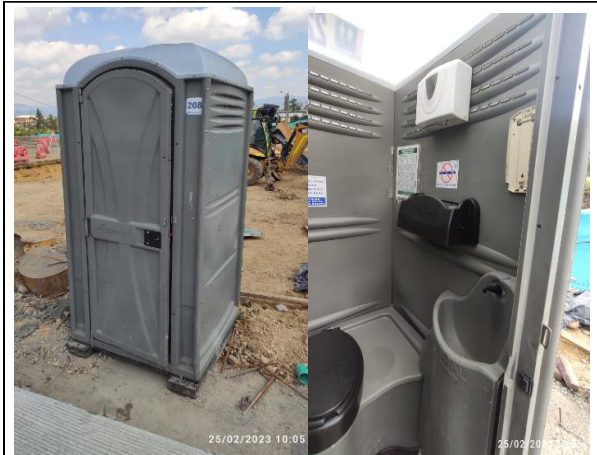
FOTOGRAFÍA N° 14 FECHA: 25-feb.-23 UF1, K2+140 peaje Fusca costado oriental: Baño portátil con lavamanos (Accenorte)
