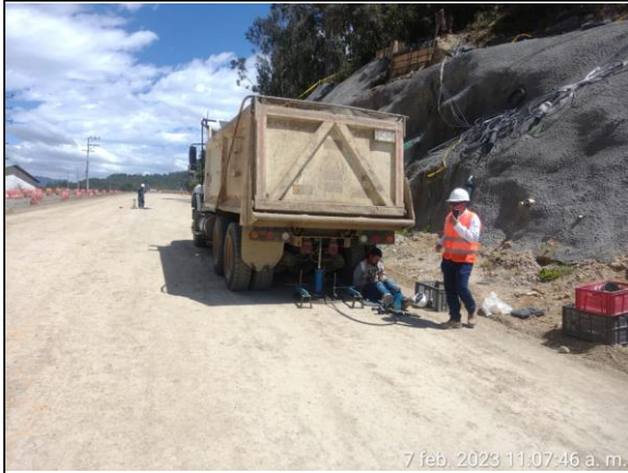
FOTOGRAFÍA N° 0023 FECHA: 07/02/2023 Desarrollo de ensayos de verificación para la conformación de calzada oriental sector Finandina
