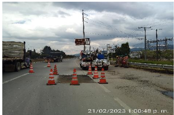
FOTOS 1 y 2: Actividades de aplicación de mezcla densa ruta 5501 PR21+900 calzada oriental, carril de baja, ejecutadas durante el mes de febrero de 2023.
