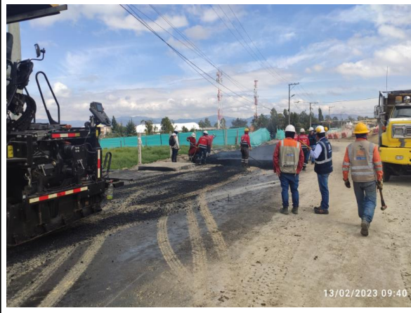
FOTOGRAFÍA N° 33 FECHA: 13-feb.-23 UF1, K2+830 Contratista, Mincivil: Trabajo en caliente por instalación de asfalto en la vía
