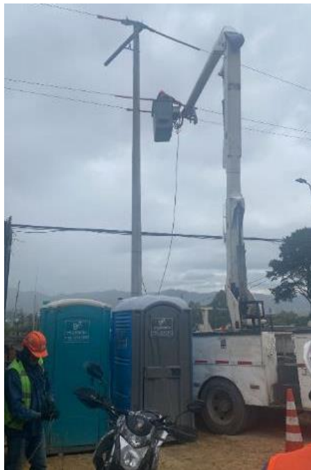
Gráfico 38 Trabajos en redes aéreas sin suspensión del servicio.
