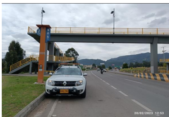
FOTOGRAFÍA N° 0016 FECHA: 20/02/2023 RN 45A04, 45ACNA, 45ACNB Verificación comunicación por medio de postes SOS con radioperadores en CCO.
