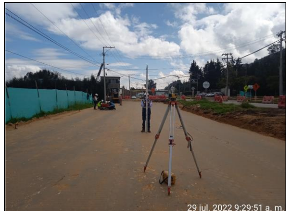
FOTOGRAFÍA N° 0012 FECHA: 29-jul.-22 DESCRIPCIÓN Verificación de niveles para corona de afirmado, entre abscisas K2+350 al K2+430, Calzada Izquierda Unidad Funcional No 1.
