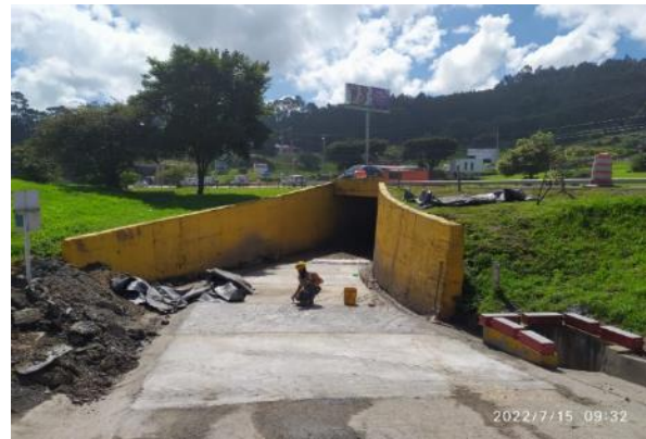
FOTOS 1 y 2: Actividades de reemplazo carpeta de rodadura de pavimento, ejecutadas durante el presente mes de julio de 2022, en Box Culvert Yerbabuena.
