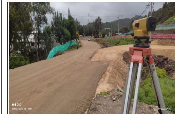
FOTOGRAFÍA N° 0005 FECHA: 11-jul.-22 DESCRIPCIÓN Verificación de niveles para sub base granular entre abscisas K3+890 al K3+980, Calzada Izquierda Unidad Funcional No 1.
