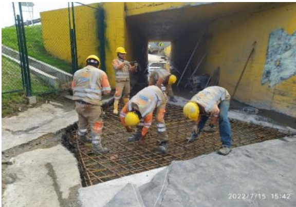
FOTOS 1 y 2: Actividades de reemplazo carpeta de rodadura de pavimento, ejecutadas durante el presente mes de julio de 2022, en Box Culvert Yerbabuena.
