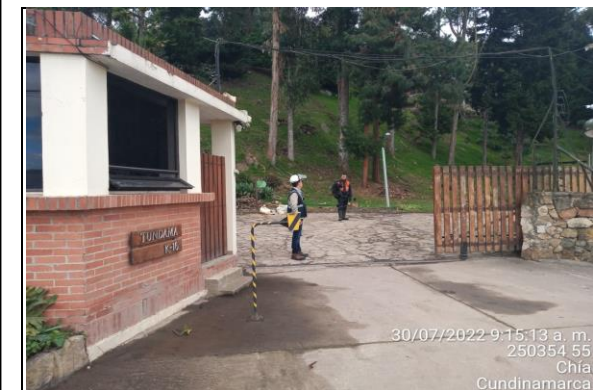
FOTOGRAFIA N° 0021 FECHA: 30/07/2022 U.F.1 K1+090 y K1+300 acceso a predios Tierra Alta y Tundama verificación estado actual carretables y sitios de intervención, futura calzada oriental.
