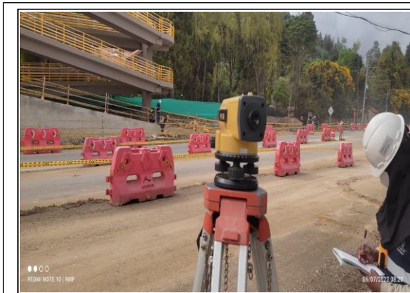
FOTOGRAFÍA N° 0003 FECHA: 6-jul.-22 DESCRIPCIÓN Control de asentamientos a columnas y rampa occidental del puente peatonal Olímpica carrera septima Unidad Funcional No 1.
