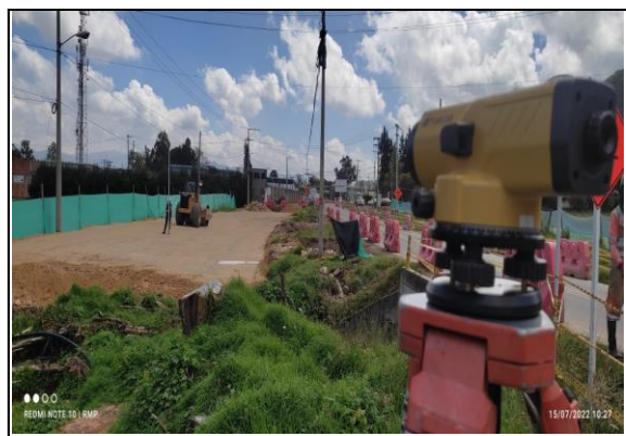
FOTOGRAFÍA N° 0008 FECHA: 15-jul.-22 DESCRIPCIÓN Verificación de niveles para terraplén entre abscisas K2+350 al K2+430, calzada izquierda Unidad Funcional No 1.
