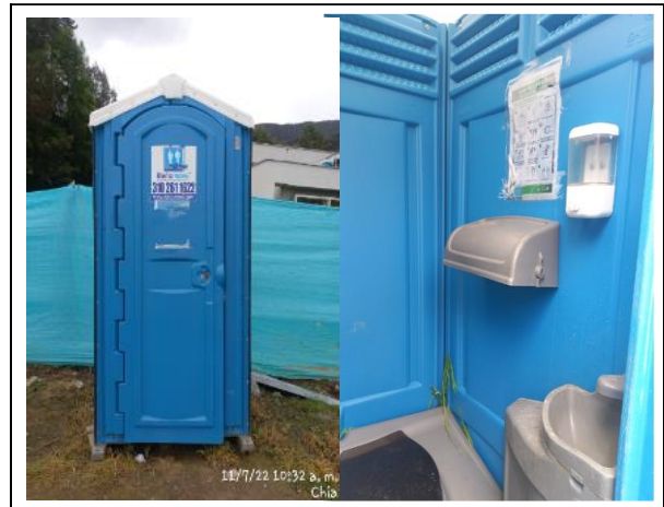
FOTOGRAFÍA N° 18 FECHA: 11-jul.-22 DESCRIPCIÓN UF1, Baño portátil disponible en costado oriental (Campamento Accenorte, PR 4+630)
