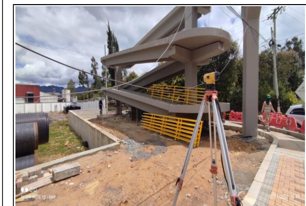
FOTOGRAFÍA N° 0007 FECHA: 14-jul.-21 DESCRIPCIÓN Control de asentamientos en muro de contención Puente Peatonal Pórtico. Unidad Funcional No 1.
