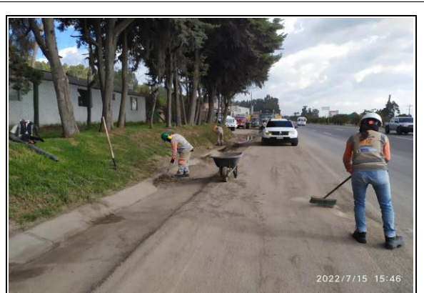
FOTOGRAFIA N° 0018 FECHA: 15/07/2022 Seguimiento desde el área de operación de interventoría RN 5501 PR8+700 Calzada Oriental. Limpieza de borde de vía.
