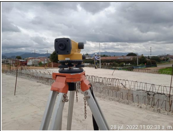
FOTOGRAFÍA N° 0011 FECHA: 28-jul.-22 DESCRIPCIÓN Control de asentamientos en placas superiores de los Box Couvert Intersección Humero. Unidad Funcional No 3.
