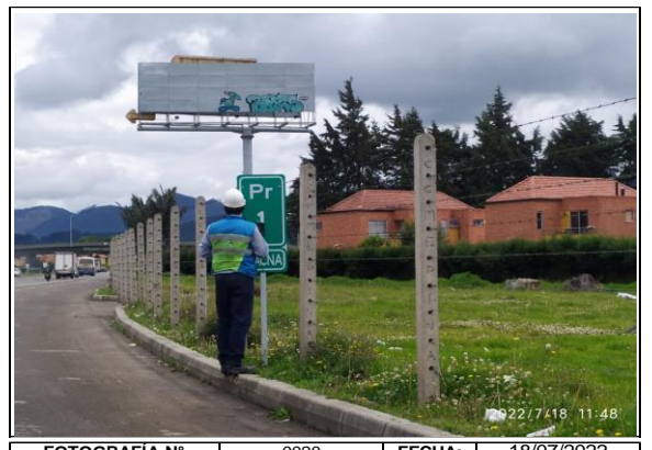
FOTOGRAFIA N° 0020 FECHA: 18/07/2022 RN 45ACNA, 45A04 Medición semestral del indicador E11 Señalización vertical, todas las señales del proyecto.
