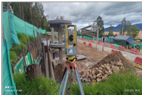
FOTOGRAFÍA N° 0006 FECHA: 12-jul.-22 DESCRIPCIÓN Levantamiento topográfico para verificar localización de dados y viga para muro de contención puente peatonal Rochester costado oriental U.F1.
