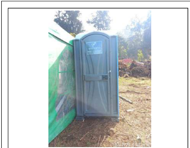
FOTOGRAFÍA N° 27 FECHA: 15-dic.-21 DESCRIPCIÓN UF1, Accenorte: Baños portátiles disponibles en Puente Peatonal Olímpica PR K3+660
