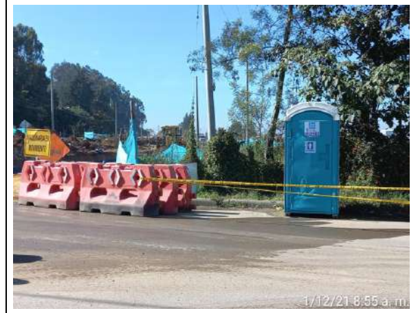
FOTOGRAFÍA N° 28 FECHA: 1-dic.-21 DESCRIPCIÓN UF1, Accenorte: Baños portátiles disponibles en intersección de puente peatonal Olímpica
