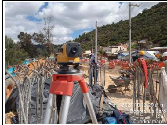
FOTOGRAFÍA N° 0004 FECHA: 7-dic.-21 DESCRIPCIÓN Levantamiento topográfico para localización de excavación y relleno entre abscisas K3+740 al K3+800, Costado Occidental. Unidad Funcional No. 1.
