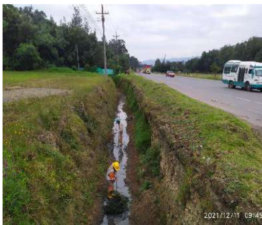
FOTOGRAFÍA° 8 FECHA: 11/12/2021 DESCRIPCIÓN PGH-3.1-08 Manejo de Aguas Superficiales. En la Unidad Funcional 4 en la RN 5501 PR16+500 Calzada Occidental se observan actividades de limpieza de drenaje longitudinal.
