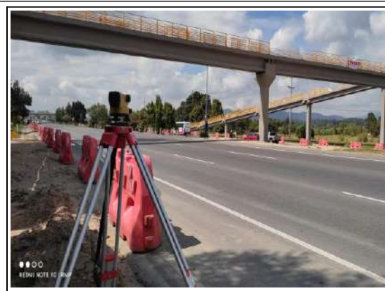
FOTOGRAFÍA N° 0006 FECHA: 10-dic.-21 DESCRIPCIÓN Verificación alturas de galibos Puente Peatonal Tinjaca Yerbabuena.
