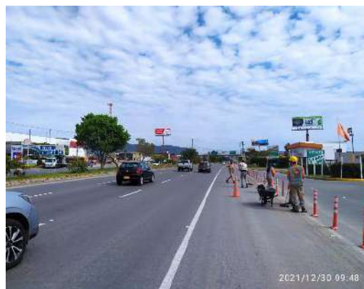
FOTOGRAFÍA° 6 FECHA: 30/12/2021 DESCRIPCIÓN PAC-2.4-07 Manejo y Disposición de Residuos Sólidos Convencionales y Especiales. Limpieza del borde vial de los residuos arrojados en la vía, los cuales son recolectados y sipuestos de acuerdo al tipo de residuo
