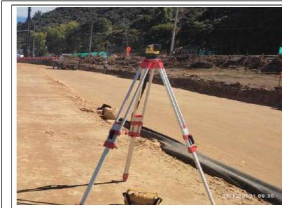
FOTOGRAFÍA N° 0005 FECHA: 7-dic.-21 DESCRIPCIÓN Verificación de niveles primera y segunda capa Calzada Izquierda del K3+460 al K3+620. Unidad Funcional No. 1.
