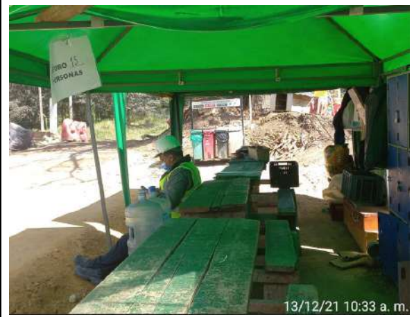
FOTOGRAFÍA N° 18 FECHA: 13-dic.-21 DESCRIPCIÓN UF1, Campamento Mincivil: Aforo de zonas comunes (RN 5501 PR3+6500)
