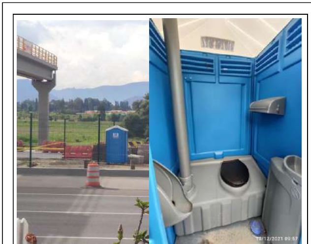
FOTOGRAFÍA N° 31 FECHA: 16-dic.-21 DESCRIPCIÓN UF4, Puente peatonal Ladrillera: Baños portátiles disponibles en calzada occidental
