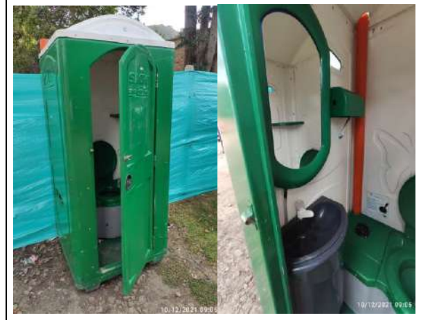
FOTOGRAFÍA N° 26 FECHA: 18-dic.-21 DESCRIPCIÓN UF1, Campamento Solimpro: Baños portátiles disponibles en calzada oriental, Puente peatonal Pórtico
