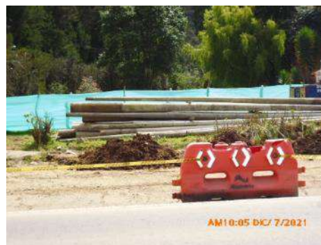
Postes de concreto retirados y acopiados para disponer en posibles reutilizaciones
