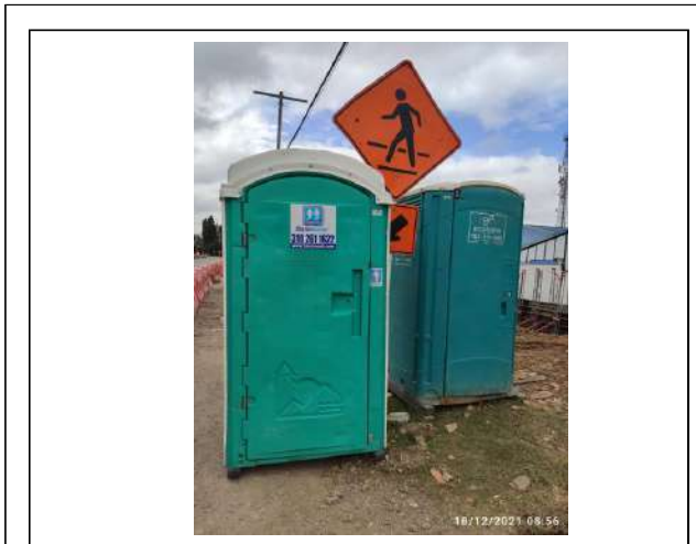
FOTOGRAFÍA N° 25 FECHA: 18-dic.-21 DESCRIPCIÓN UF1, Campamento Pilotes profundos: Baños portátiles disponibles en calzada occidental, Puente peatonal Pórtico
