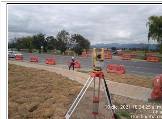
FOTOGRAFÍA N° 0007 FECHA: 10-dic.-21 DESCRIPCIÓN Levantamiento topográfico de espacio público para puente peatonal Price Smart costado oriental y occidental.
