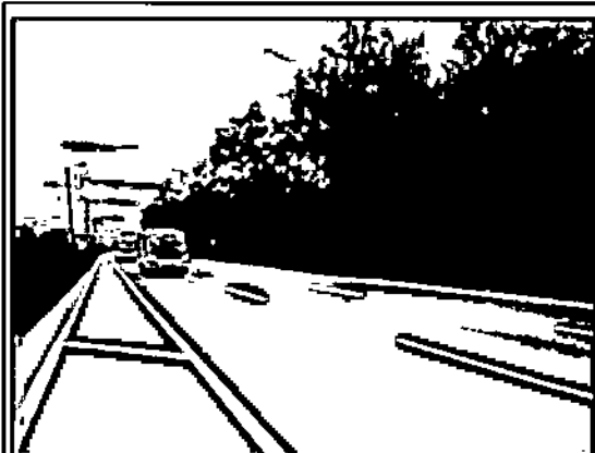
IMAGEN N° 23 FECHA: Abd-2017 DESCRIPCIÓN Pavimentación PR 1+650 Rta ISA04 Antioquia Norte, separador - Calzada izquierda, vista sur.
