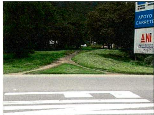
K1+600 Separador, margen izquierda, labores de rocería.
