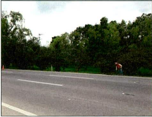
K5+300 Separador, margen derecha, labores de limpieza.
