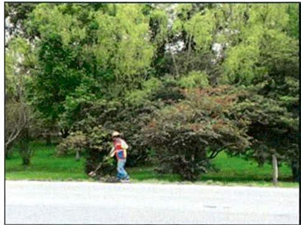
K5+300 Separador, margen derecha, labores de limpieza.
